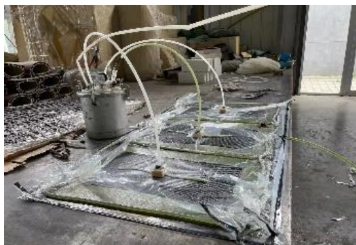
(b) GFRP板制作
