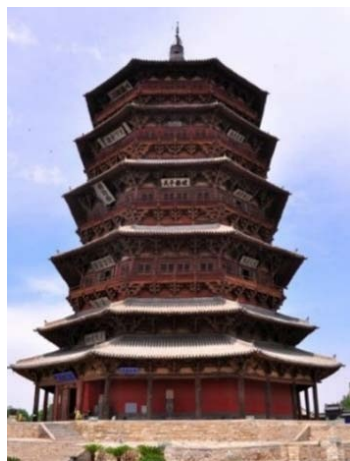
图 1 应县木塔实景图
